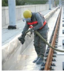
Figura 12.8.4.2.6.a - Applicazione a spruzzo della membrana impermeabile
